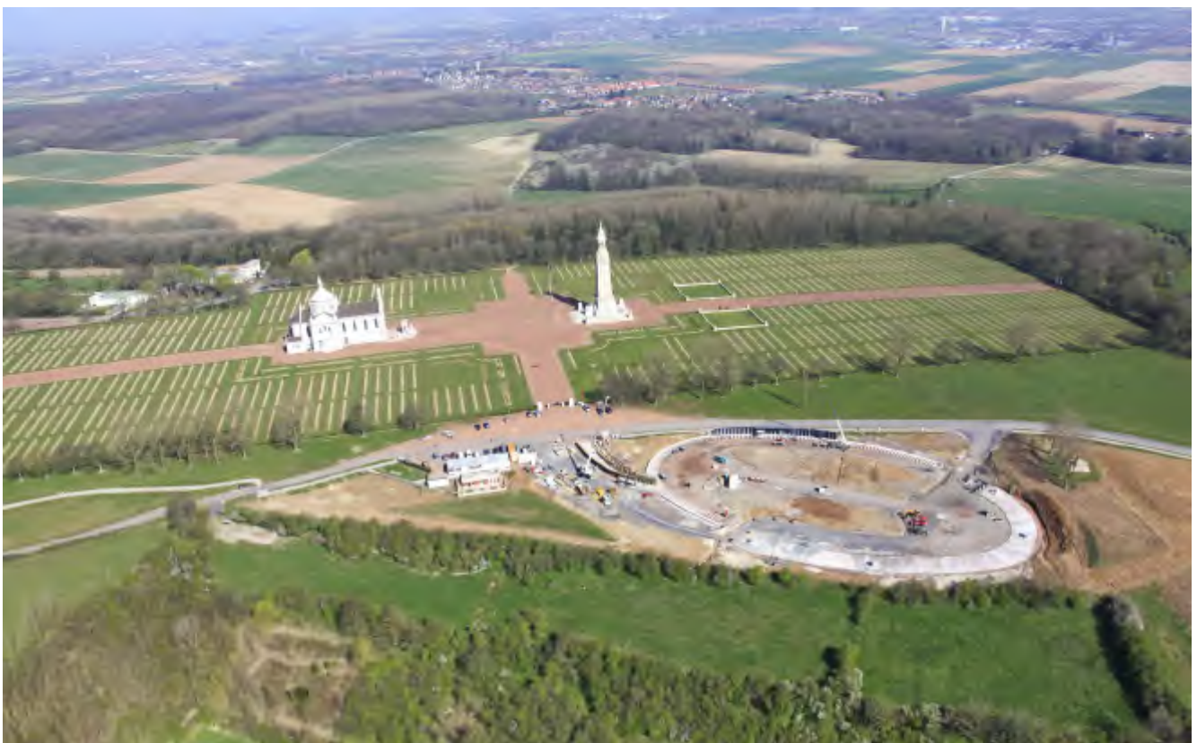
Vue aérienne du chantier en avril 2014 / photo Sophie Bocquet
